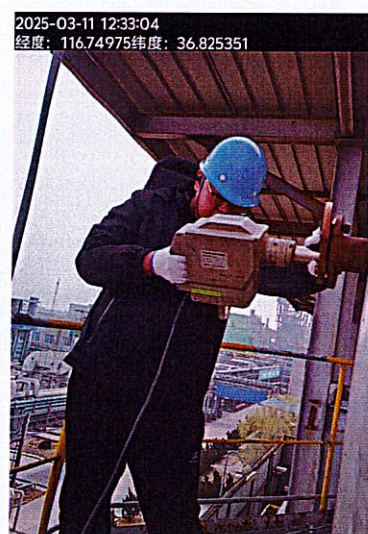
4#燃气轮机组排气筒 (DA019)
